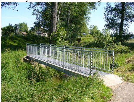
Nový mostek u zastávky ČD
